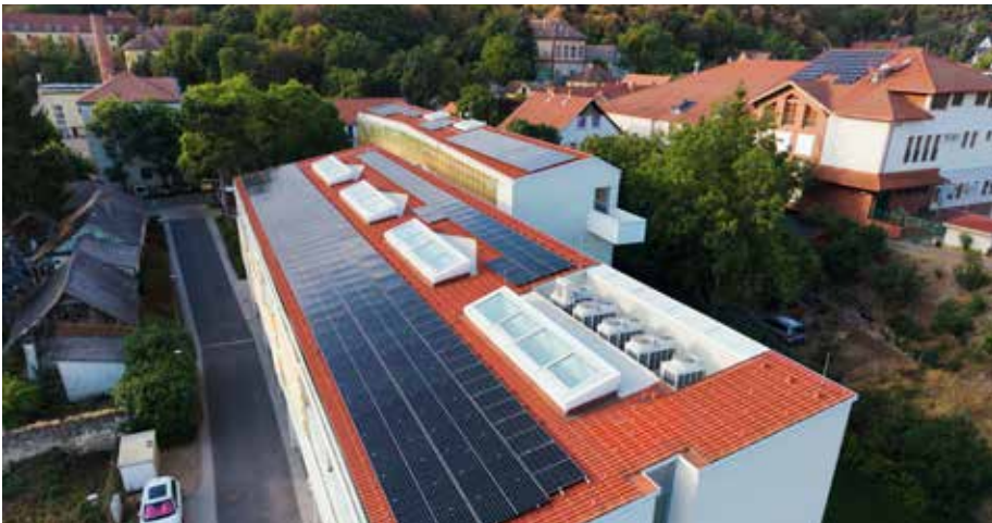
A napelemes rendszerek telepítése hozzájárul a modernizációhoz
